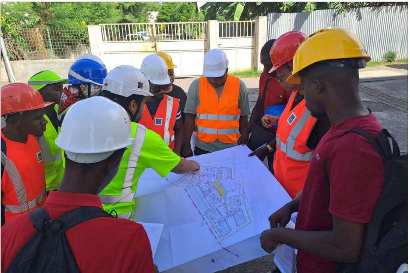
Les étudiants ont été ravis de se déplacer sur le chantier "Le Moya" qui leur a permis de sortir du cadre essentiellement théorique de leur formation, en se projetant vers un avenir concret pour l'exercice de leur futur métier.
